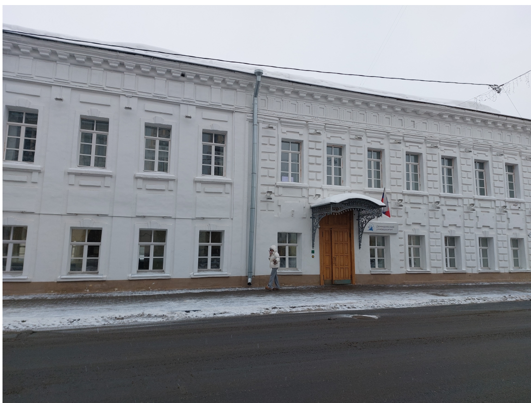
Второй корпус ЯрГУ. Январь 2026 г.
